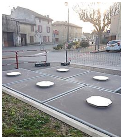
(A gauche) Emplacement des futures colonnes qui seront installées sur le parking de la poste
